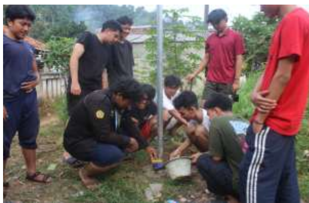
Gambar 5. Pemasangan lampu panel surya
