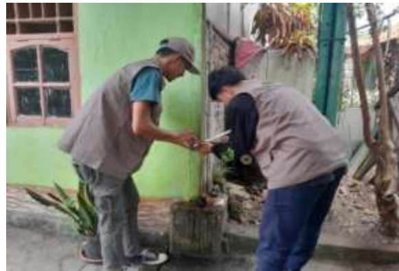
Gambar 6. Pemasangan Alat (Pipa) dan Keran Otomatis
