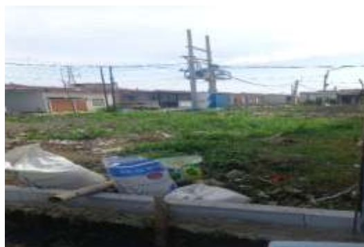
Gambar 6. Kondisi awal lingkungan
