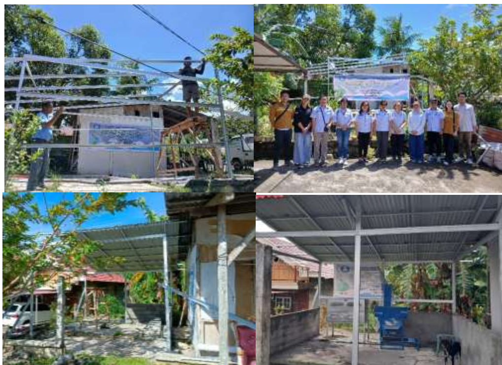
Gambar 7. Proses Pembangunan Tempat Pengolahan Sampah Plastik
