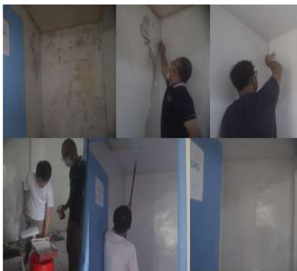
Gambar 6a. Pengecatan dinding dan plafon ruang UKS
