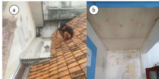
Gambar 5. Perbaikan kebocoran (a) dan pemasangan plafon (b)
