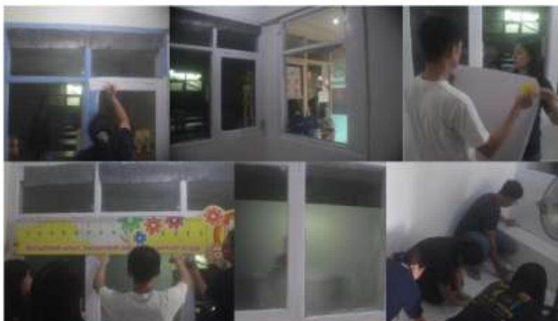
Gambar 6c. Pengecatan kusen, pemasangan stiker etched, dan pembersihan
