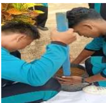
Gambar 1. Proses Pemadatan dan Perataan Adukan pada Cetakan Ember
