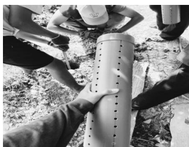
Gambar 3. Kegiatan pemasangan biopori
