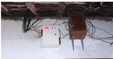
Gambar 13. Lokasi Titik SwitchHub Utama (Tengah)
