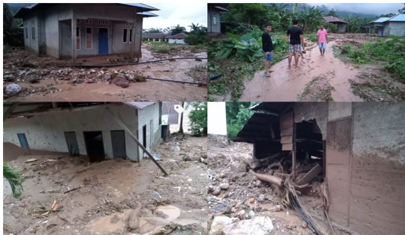
Gambar 5. Dampak longsor yang terjadi di Desa Wulur Kecamatan Damer
