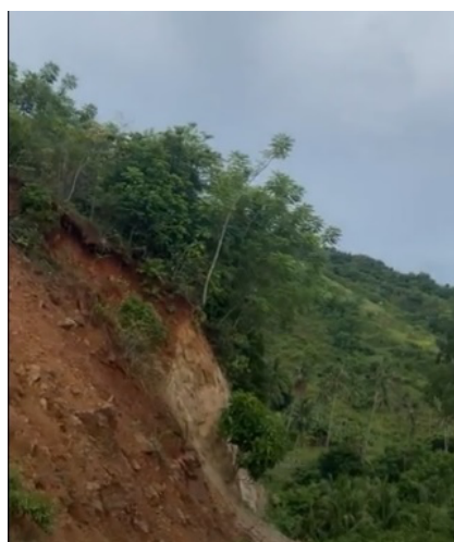
Gambar 2. Survei Lokasi Lereng Bukit
