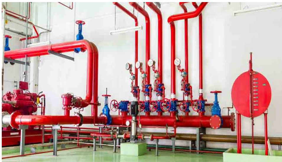
Gambar 2. Komponen Hydrant dan pemipaan
