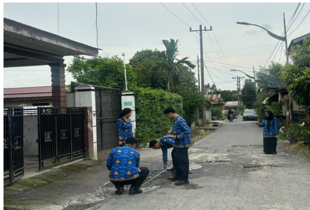
Gambar 3. Survei Kondisi Lubang Jalan Sebelum Perbaikan
