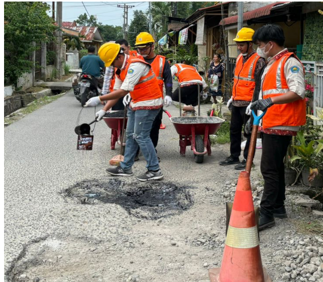
Gambar 5. Kegiatan PKM Perbaikan Jalan Berlubang di Jalan Irigasi
